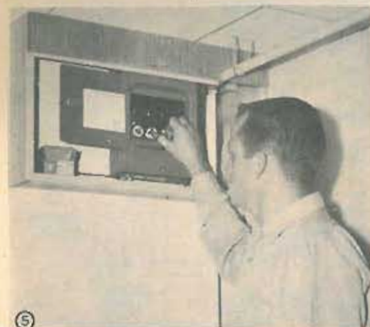
Disponendo di un'officina con parecchi utensili azionati elettricamente, è consigliabile montare il quadro secondario nell'officina stessa, con le derivazioni per i singoli motori.
